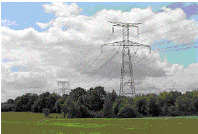
Ligne électrique à double circuit 400 000 volts existante
