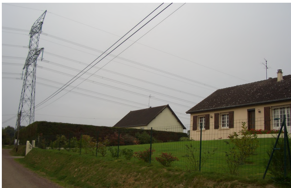
La ligne existante à Saint-Sébastien-de-Raids, au Nord de la vallée de la Taute
