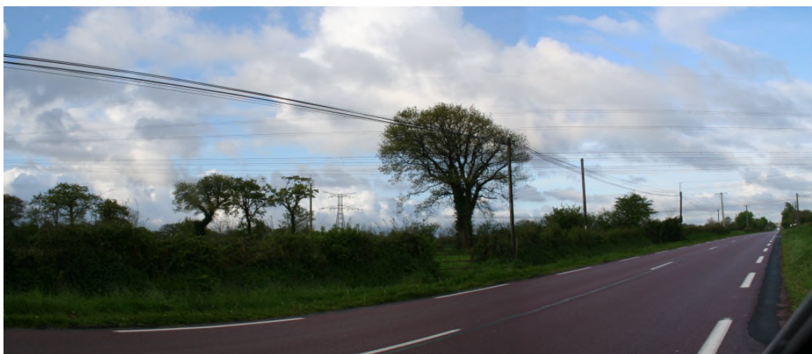
Vue vers le poste amont depuis le Scy
