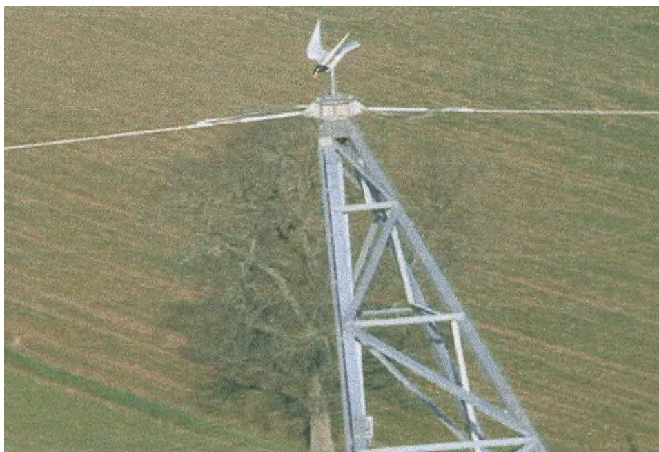
Des silhouettes de rapaces pour effaroucher les oiseaux (Modèle déposé AMBE/EDF CERT)
