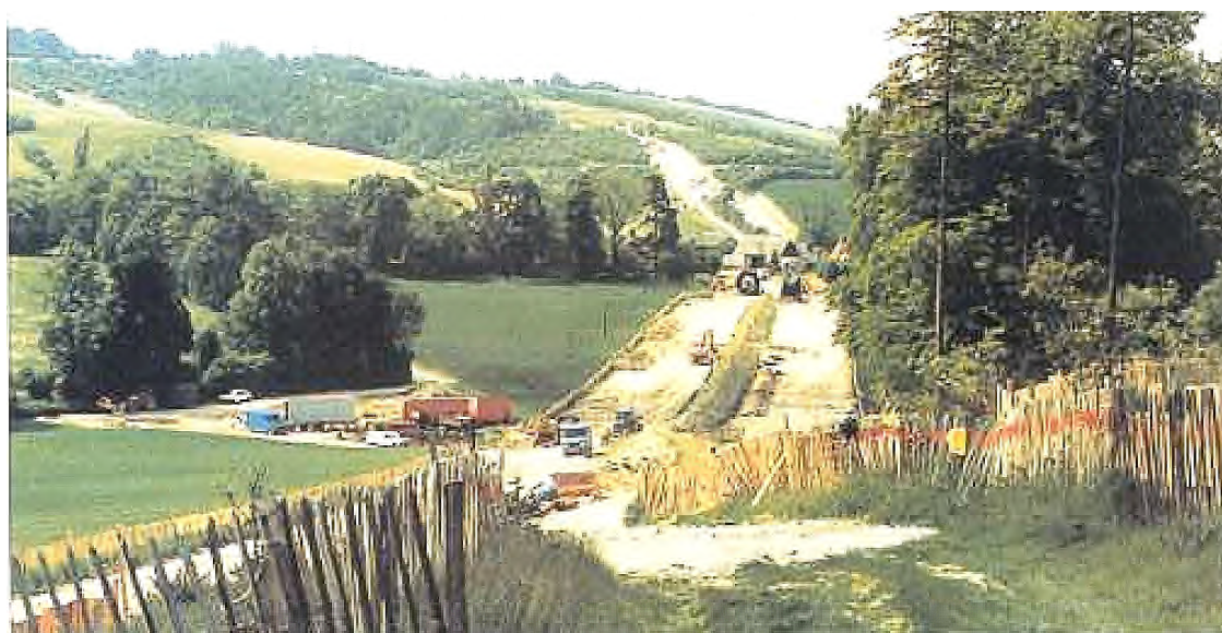
Chantier d'une liaison 400 000 volts en Angleterre
