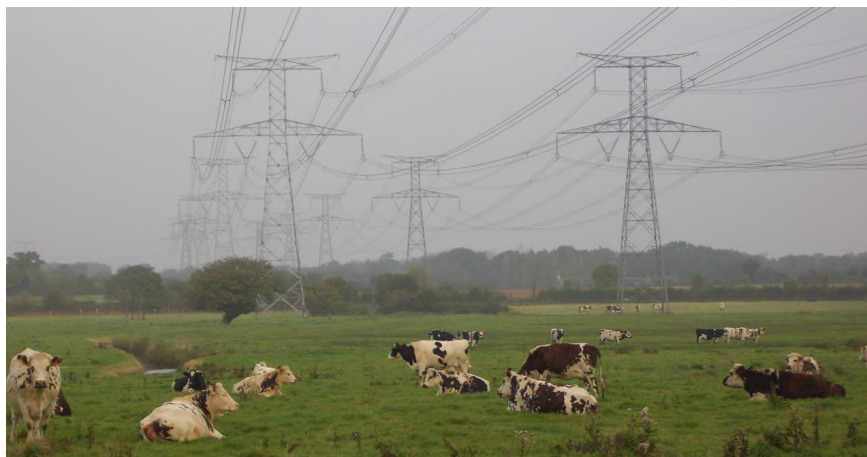
Les lignes à 2 circuits 400 000 volts vers Les Rivières
