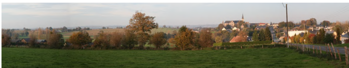
Juvigné dominant sur son coteau, renforçant ainsi le rôle de point d'appel et de repère de son clocher
