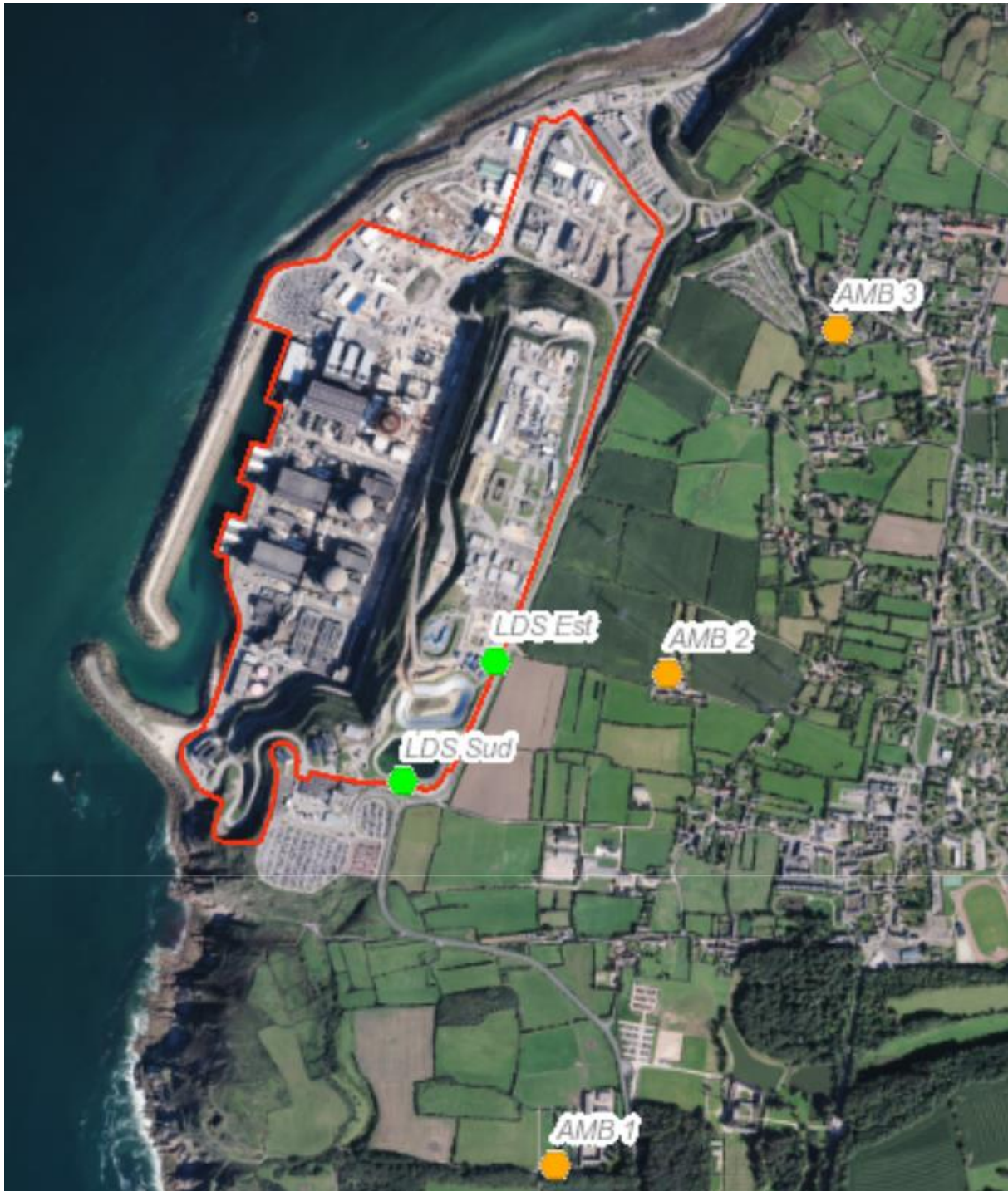
Figure 8.j : Implantation des points de mesure en LDS et en ZER du site de Flamanville (campagne 2017)
